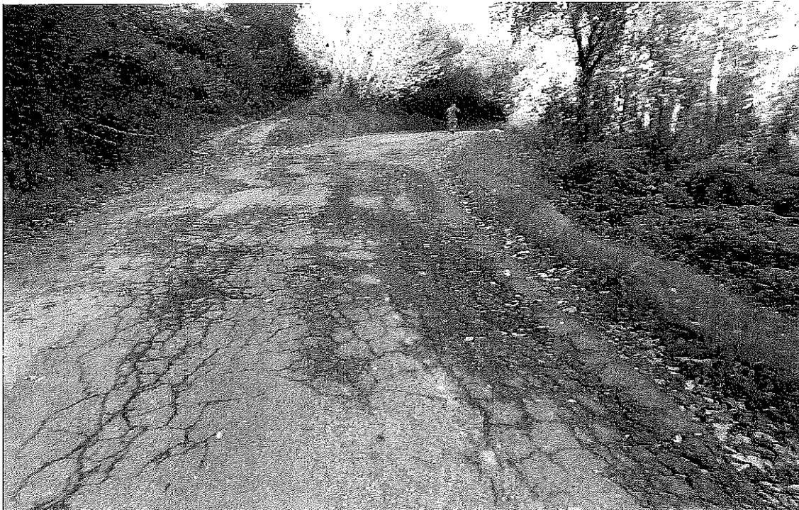
Foto 4 – Km 2+400 Fresatura (3cm)attacco inizio e fine tratto + tappeto
