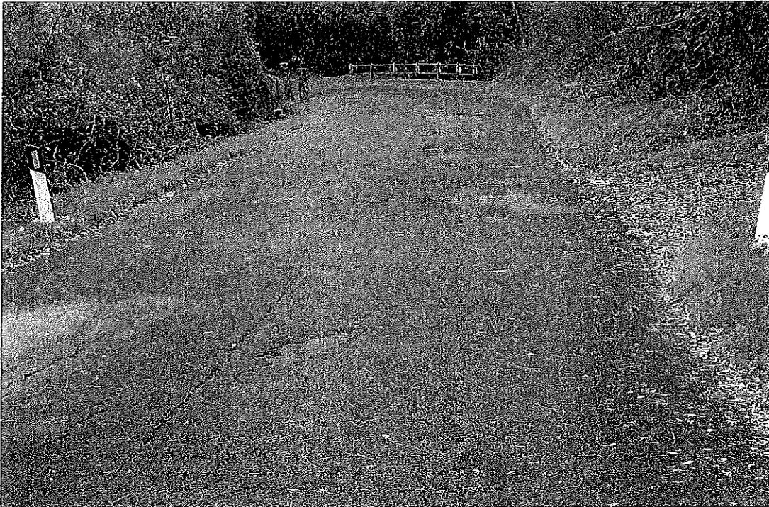
Foto 1 – Km 1+400 Fresatura (3cm)attacco inizio e fine tratto + tappeto
