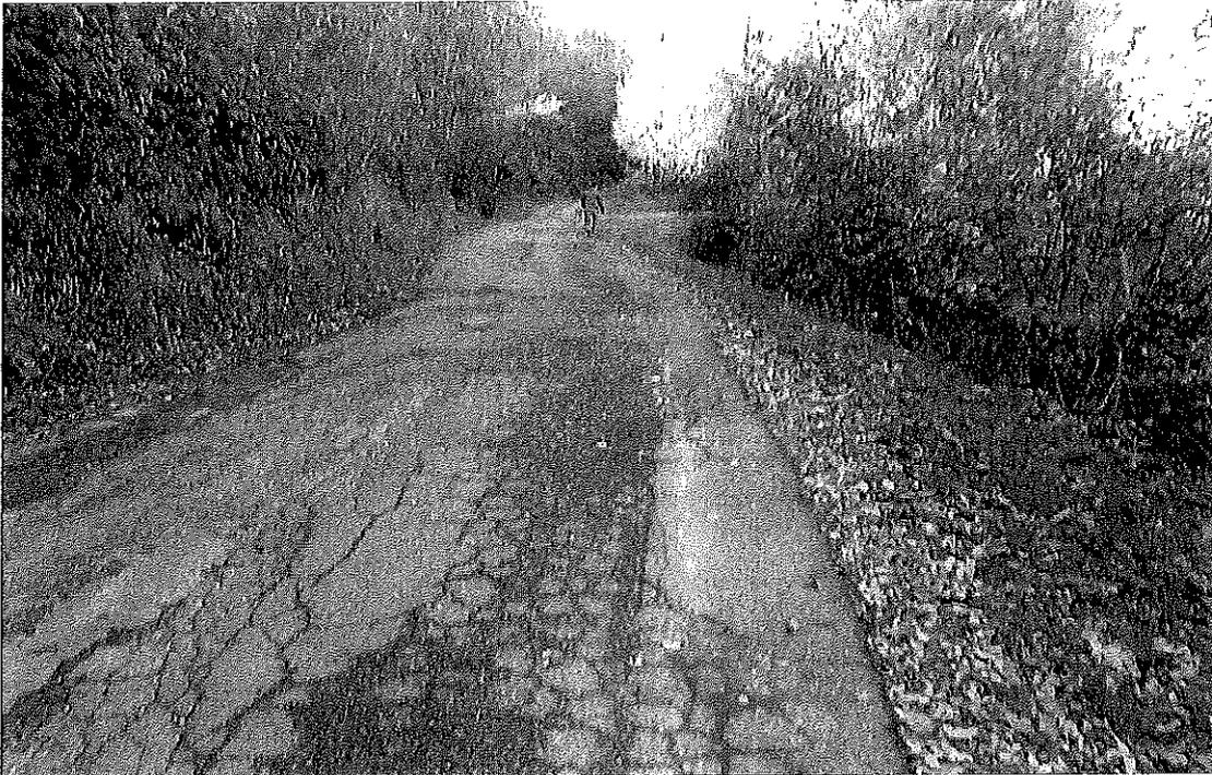
Foto 3 – Km 2+400 Fresatura (3cm)attacco inizio e fine tratto + tappeto
