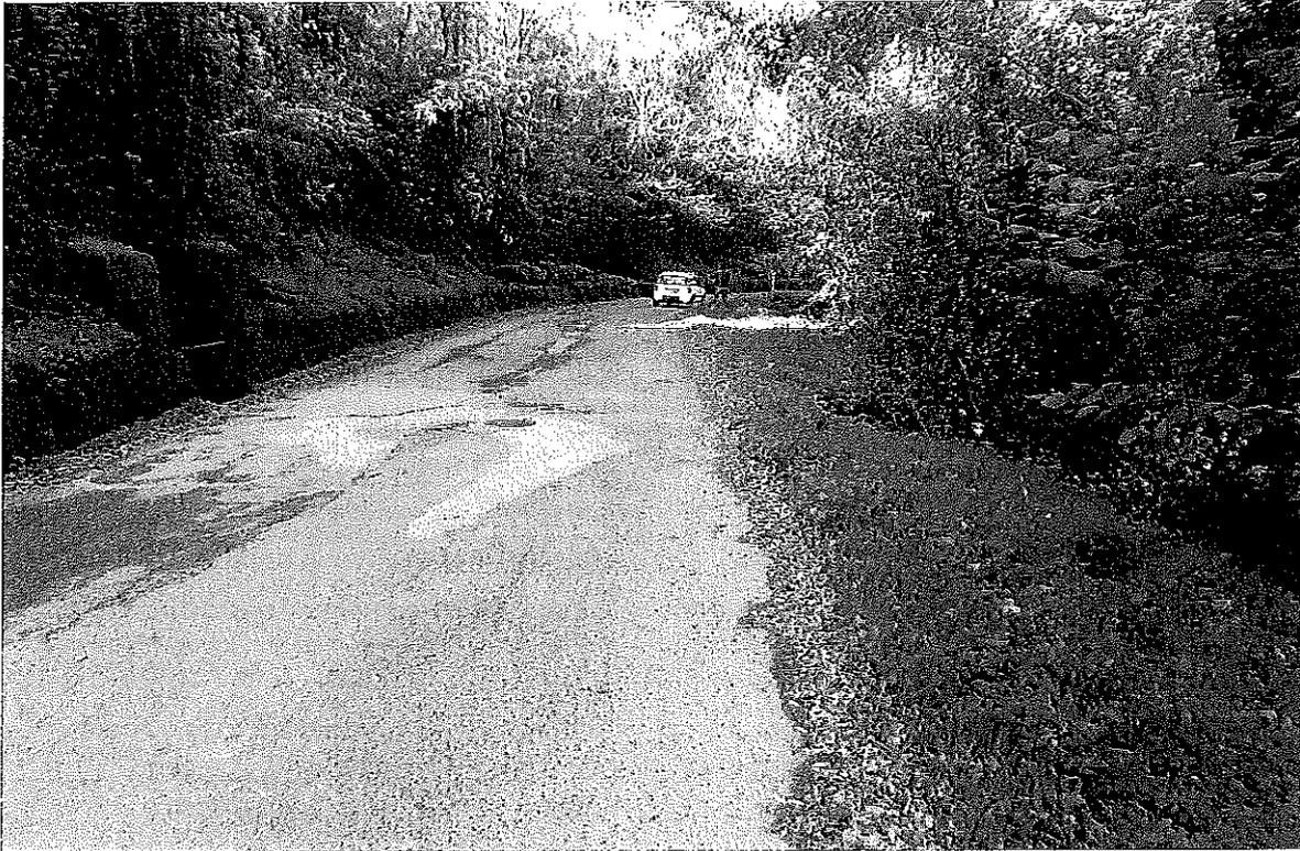
Foto 1 – Km 1 Fresatura (3cm) attacco inizio e fine tratto + tappeto
