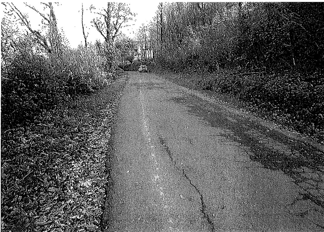
Foto 2 – Km 2+400 Fresatura (3cm)attacco inizio e fine tratto + tappeto
