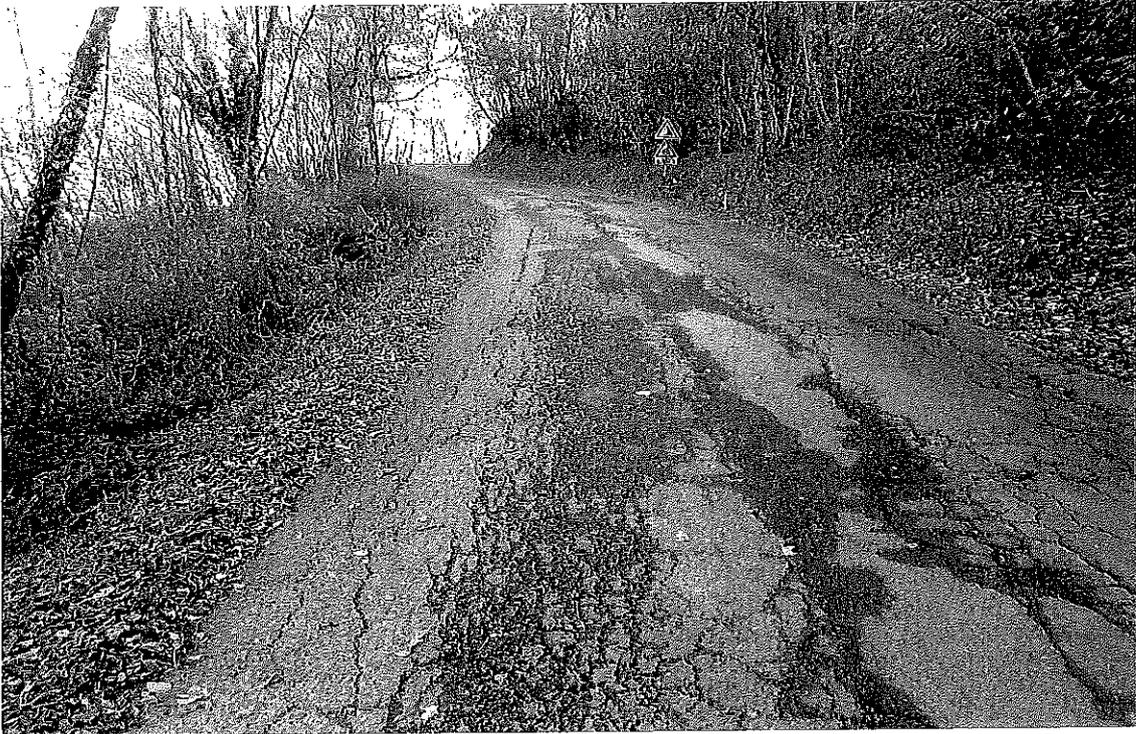
Foto 5 – Km 2+800 Fresatura (3cm) attacco inizio e fine tratto + tratti di ricarica +tappeto
