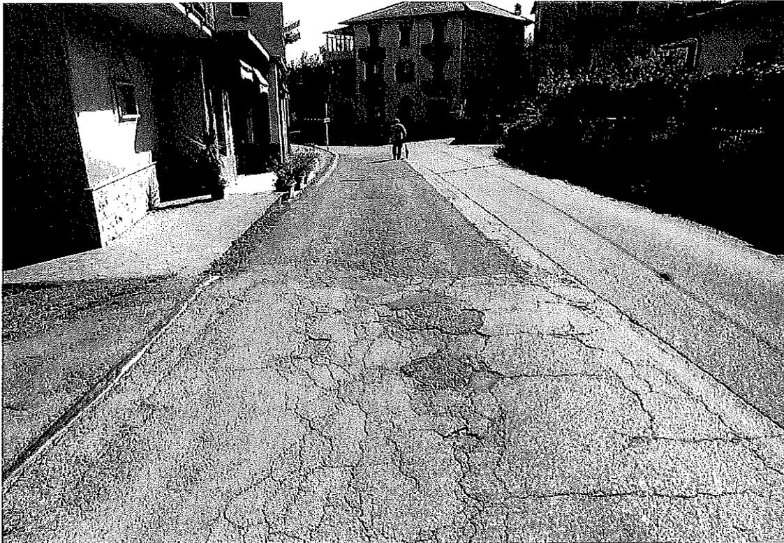
Foto 1 – Km 1 Tratto di corsia davanti fabbricato, problematiche di quota con marciapiede, necessità di fresatura (3cm) + tappeto
