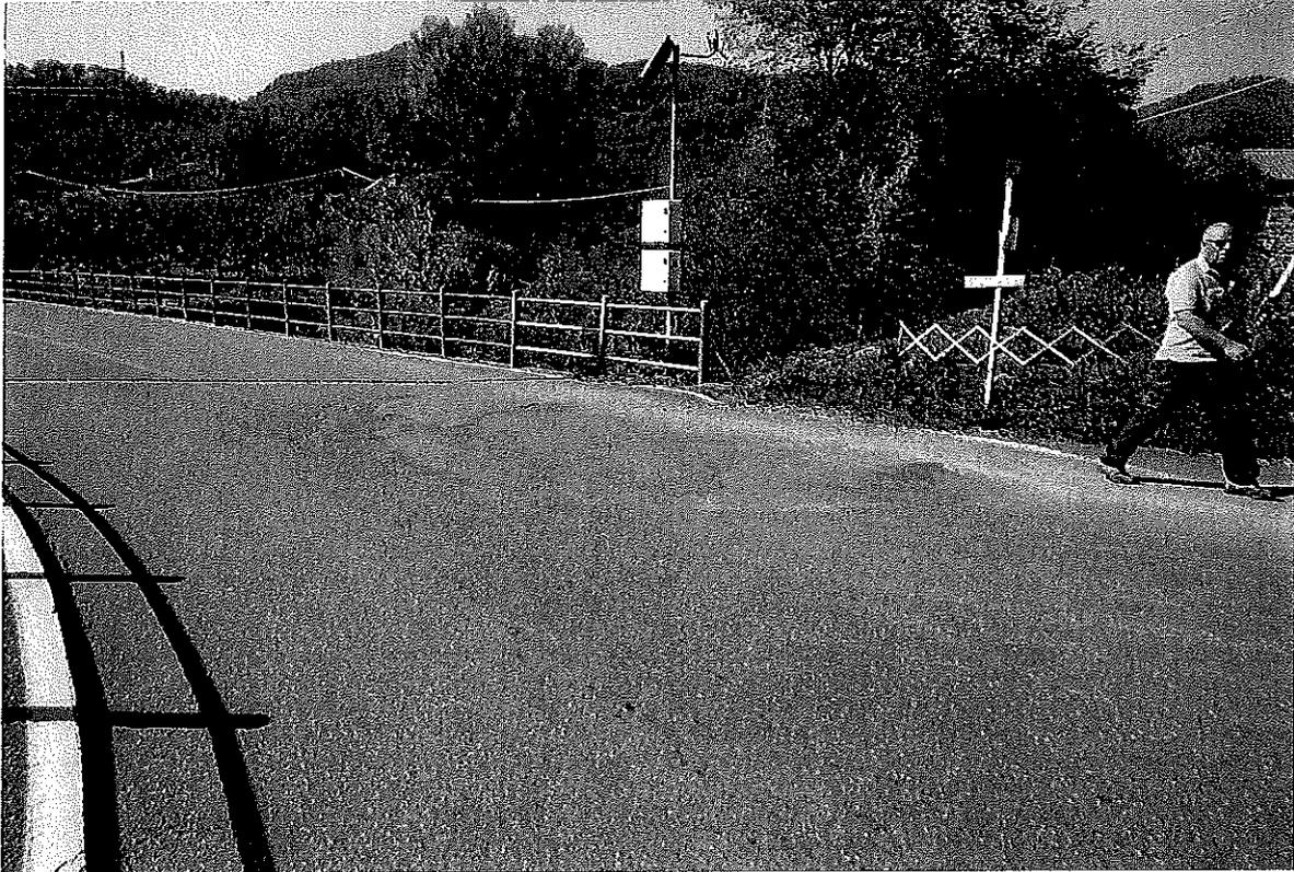
Foto 13 – Ponte Teglia Km 7+500 ( incrocio x diga di Teglia ) 30mq di abbassamento piano stradale
