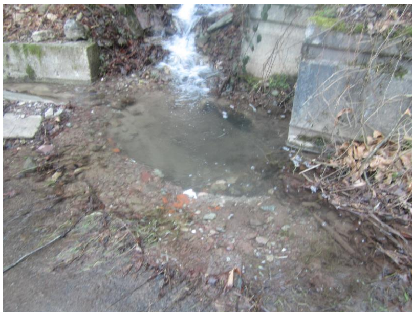
Foto 3.8 – Acqua non afferente al pozzetto esistente.
